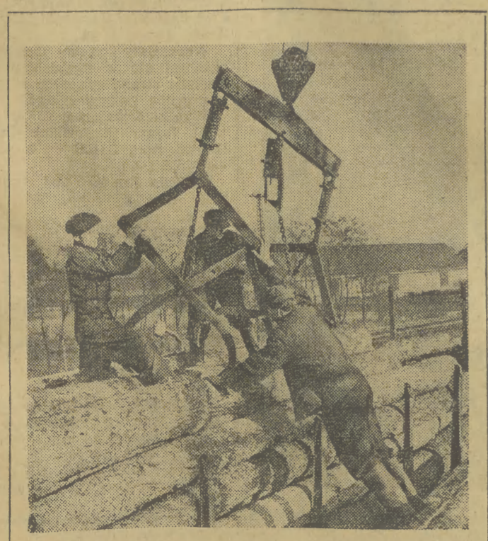
Tartak w Krzeszowicach zazwyczaj swoje sukcesy zorganizowaniu pracy według produkcyjnej metody inż. Kowalowa. Na zdjęciu: wyładowywanie surowca za pomocą zmechanizowanego dźwigu
