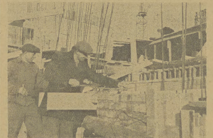
Mimo mrozów, na budowie MDM trwa nieprzerwanie praca.
