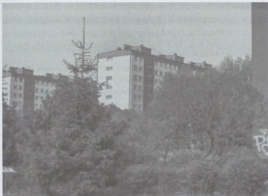
Fot. 12. Osiedle Strusia (źródło: fot. aut.)
