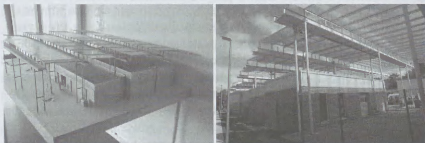
Fot. 18, 19. „Welt-Gewerbehof” – model w siedzibie IBA-Dock oraz obiekt w budowie, Wilhelmsburg-Hamburg 2013 (źródło: fot. aut.)
