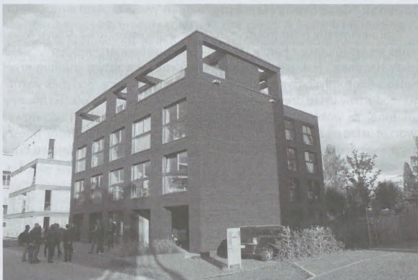
Fot. 7. Budynek "Case Study #1", Hamburg (źródło: fot. aut.)
