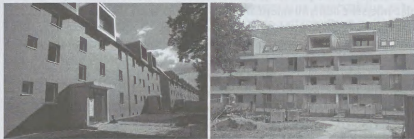
Fot. 16, 17. „Weltquartier”, budynki mieszkalne z lat 30-tych w trakcie modernizacji, Wilhelmsburg-Hamburg 2013 (źródło: fot. aut.)
