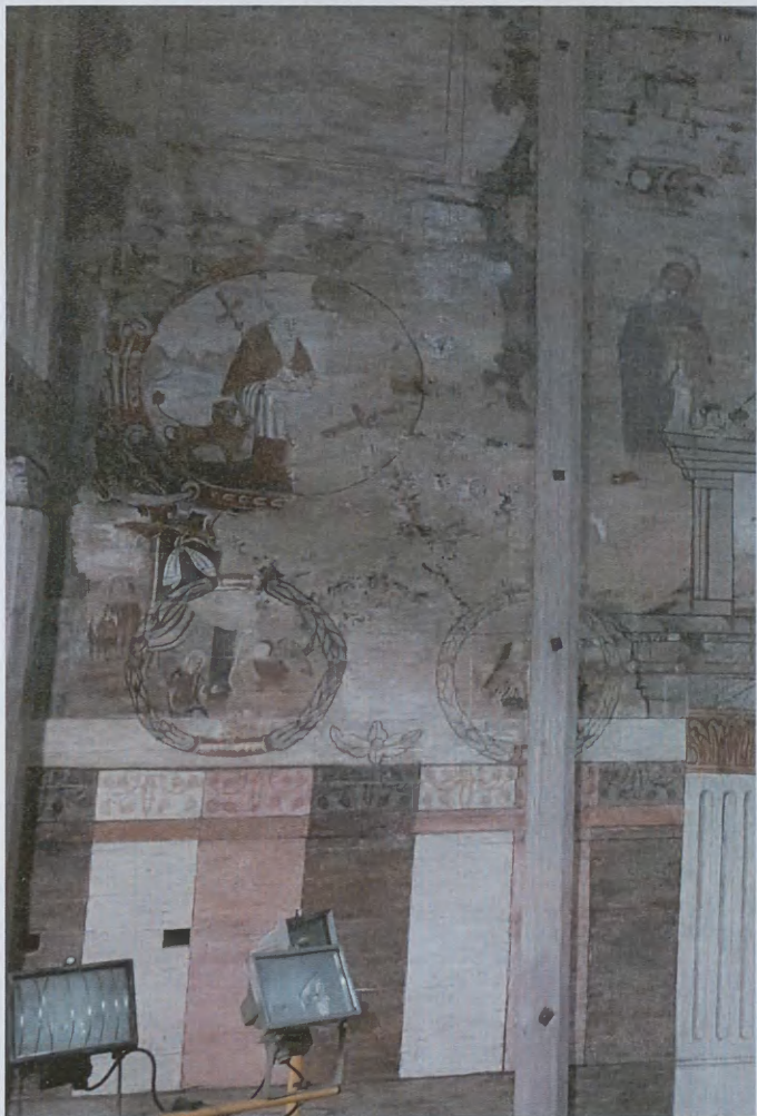
Kościół w Siemiechowie. Odkrywka polichromii w prezbiterium nad wejściem do zakrystii.
