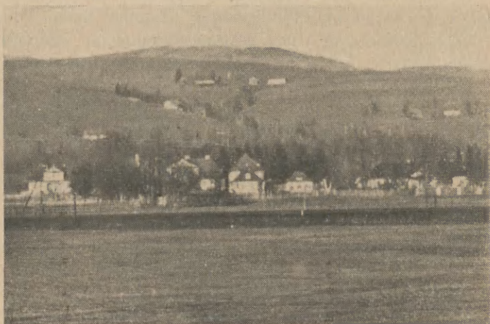
Fot. 6. Ogólny widok budynków szkolnych.
