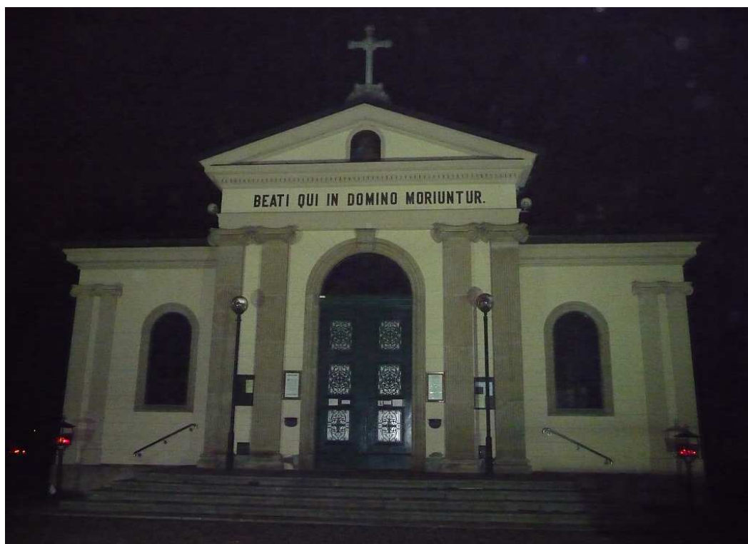
Fot. nr 14. Kaplica cmentarna. (31.10.2011)
