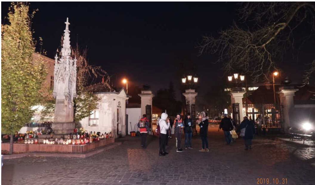
Fot. nr 281. Brama od strony ulicy Rakowickiej.
