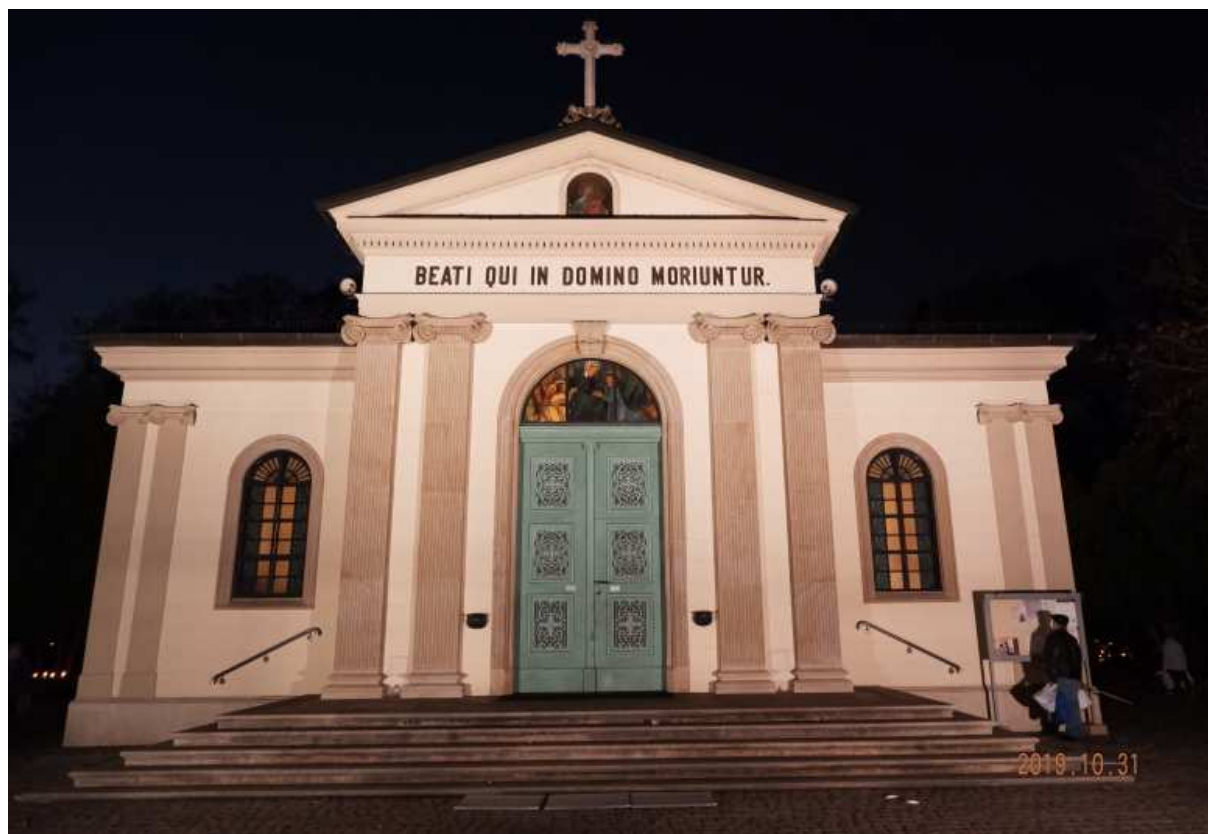
Fot. nr 283. Kaplica cmentarna.
