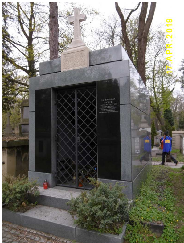
Fot. nr 84. Przykład kontrowersyjnego sposobu odnowy. Blichtrz dociera również na tę piękną metropolię.
