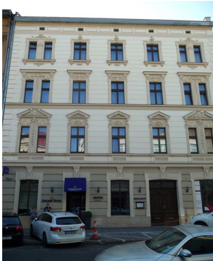
Fot. nr 207. Świeżo odnowiona kamienica pod nr 8 z końca XIX wieku. (17.09.2014)
