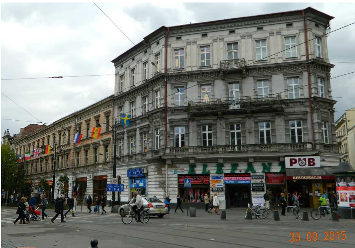
Fot. nr 223. Fragment zabudowy o numerach 5-7. Narożna kamienica (nr 7) powstała w latach: 1872-1878.
