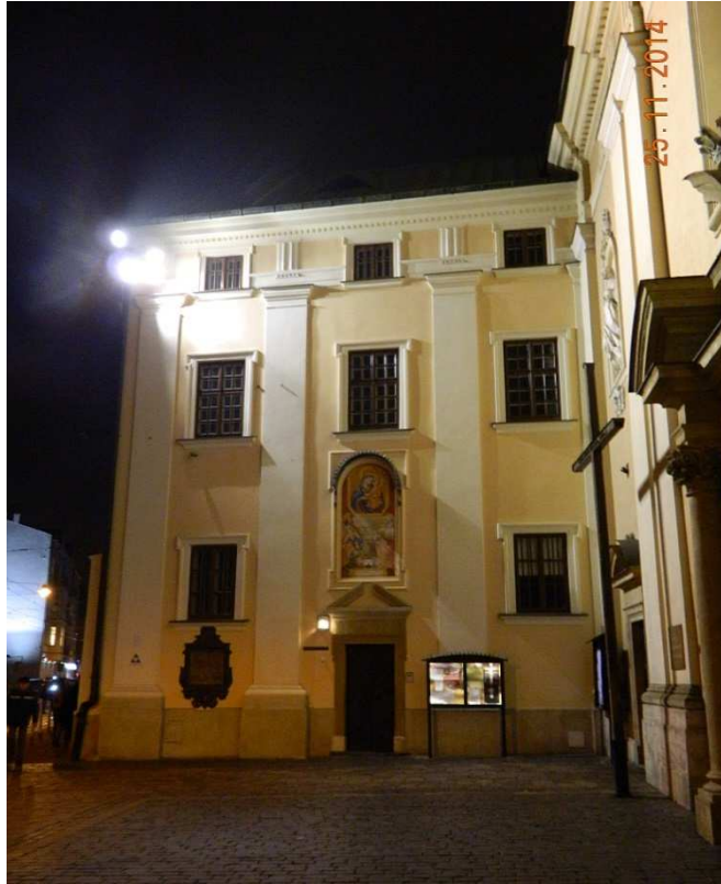
Fot. nr 112. Wnęka nad wejściem ponownie zapełniona odnowionym obrazem.
