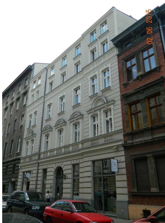
Fot. nr 5. „Moja” kamienica przy ulicy Czystej 8 po zeszczeniu nadbudową o dwa piętra.
