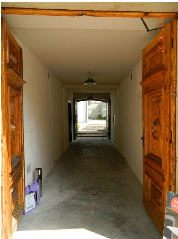
Fot. nr 180. Przelotowa sień.
