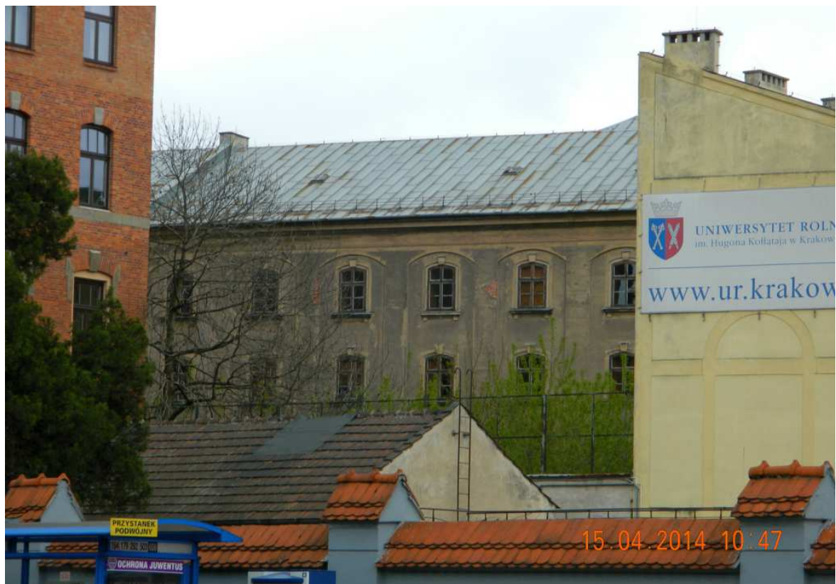
Fot. nr 12. Budynek fabryczny „tytoniary” (dawnych KZT) od strony alei Mickiewicza.
