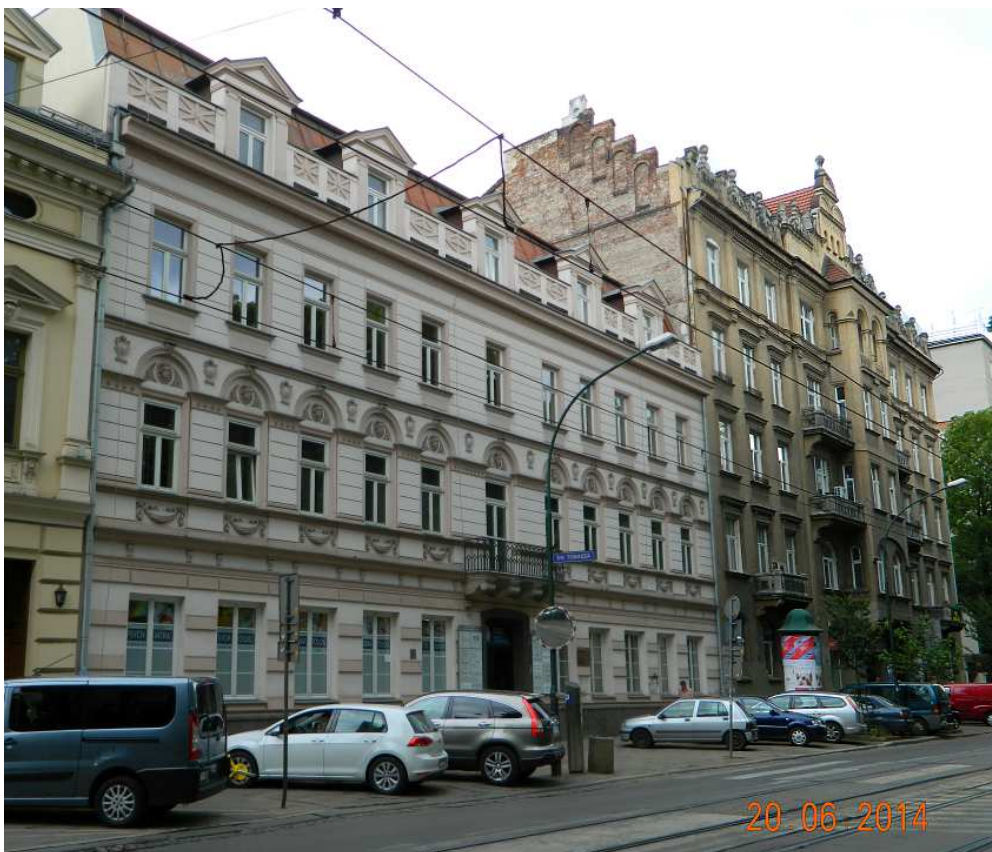
Fot. nr 219. Nadbudowana kamienica spod nr 5 z lat 1838-48.
