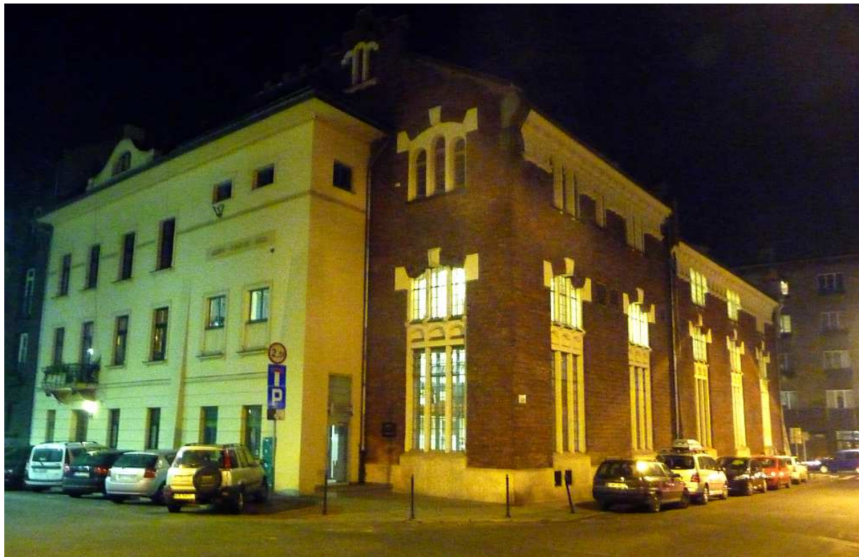
Fot. nr 201. Ponad stuletni budynek podstacji tramwajowej przy ulicy Biskupiej 1/Asnyka 12. (18.12.2013)
