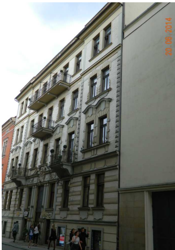
Fot. nr 155 (155-156). Kamienica spod nr 3, wybudowana w roku 1906..
