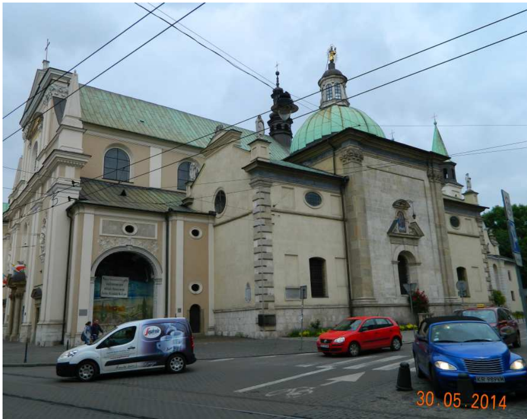
Fot. nr 123 (123-125). Południowy fragment kościoła od strony ulicy Garbarskiej. Pośrodku zwieńczona kopułą kaplica matki Boskiej Piaskowej.
