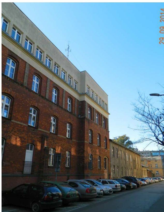
Fot. nr 189 (189-190). Końcowy fragment ulicy Siemiradzkiego. Tu widok z wylotu ulicy Lenartowicza. Na pierwszym planie nadbudowany o trzecie piętro budynek dawnych Koszar Obrony Krajowej pod nr 24.
