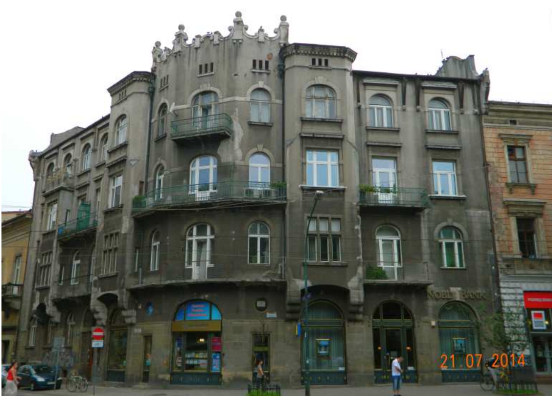
Fot. nr 225. Kamienica Federowiczów spod nr 4, która została ukończona w roku 1911 w miejscu tzw. „baszty Kościuszki”.
