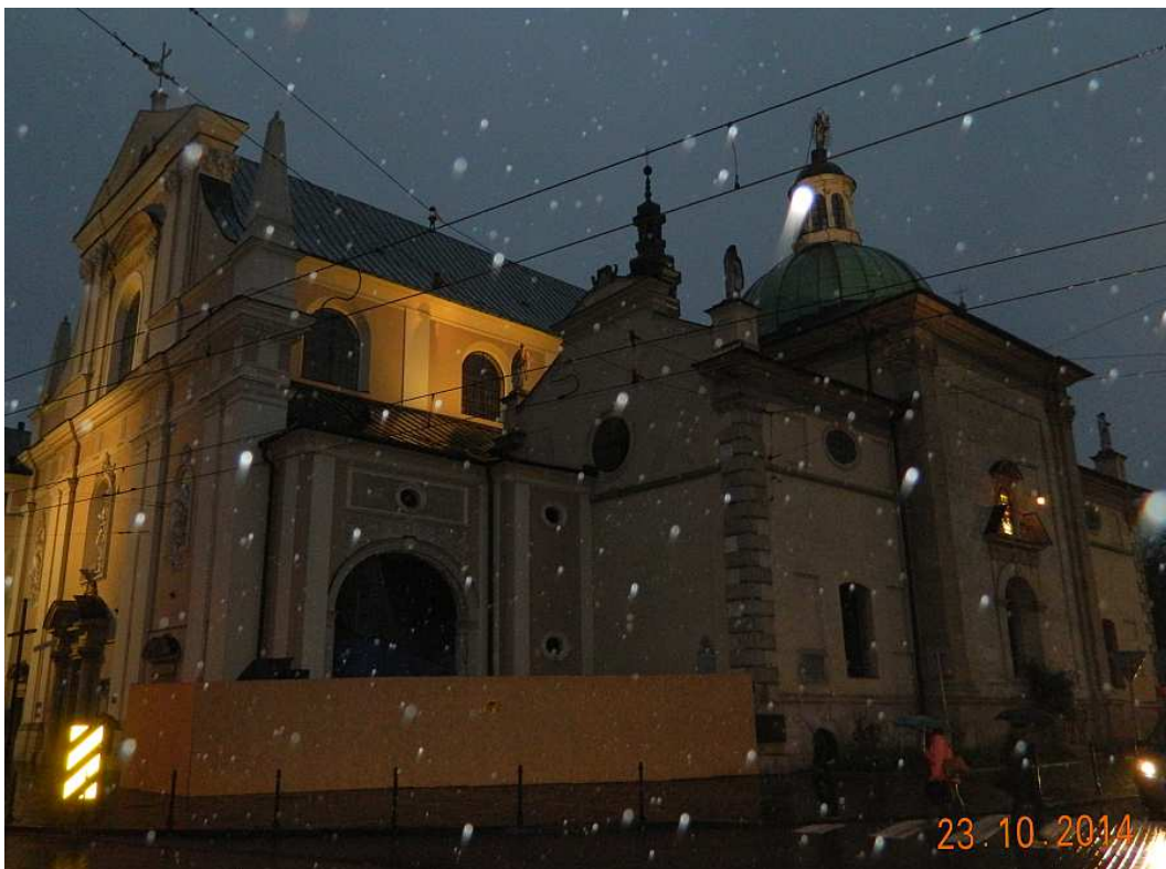
Fot. nr 119. Fragment kościoła od strony ulicy Garbarskiej, z XVIII-wieczną Golgotą (tu w trakcie odnowy) oraz kaplicami: Matki Boskiej Piaskowej i Matki Boskiej Szkaplerznej.
