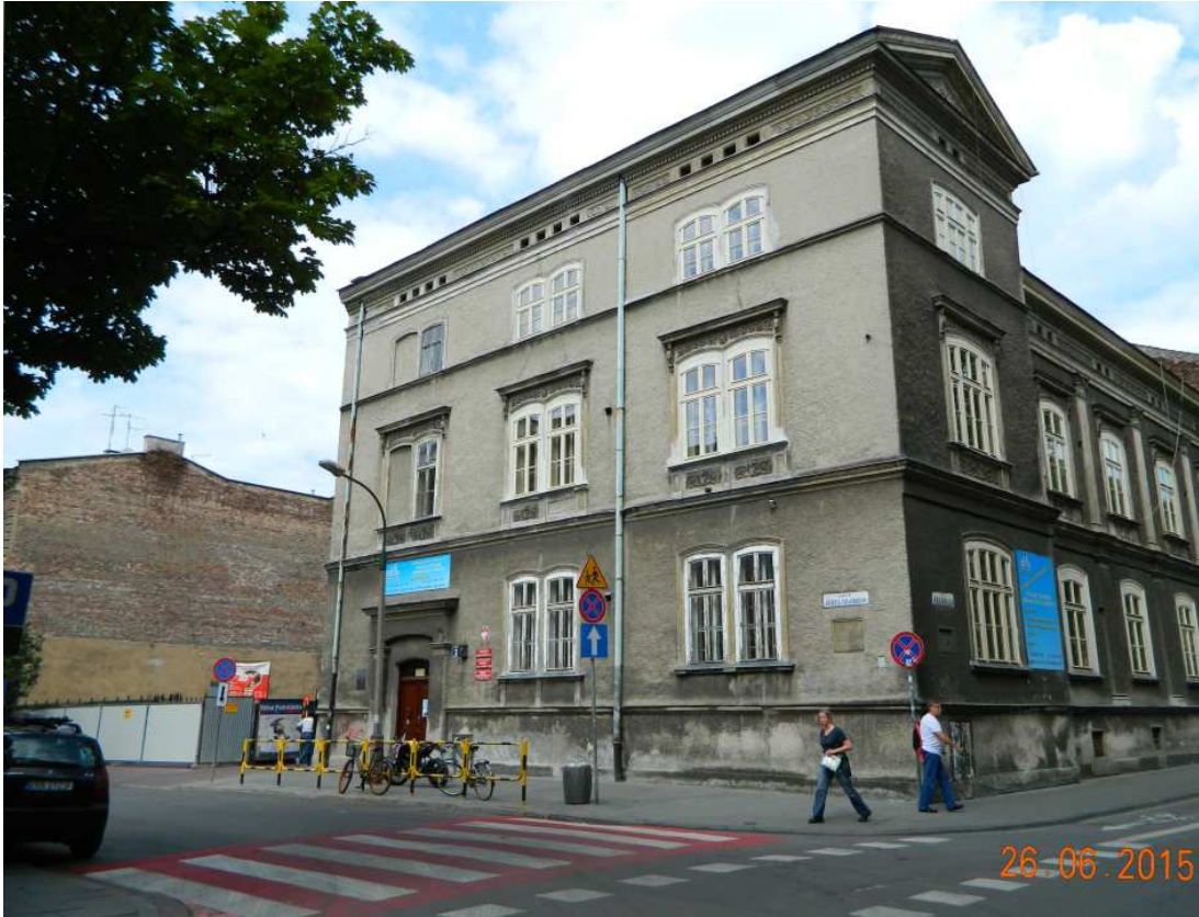
Fot. nr 174 (174-175). Budynek dawnej SP nr 6 przy ulicy Szujskiego 2 i zmieniające się jego sąsiedztwo.
