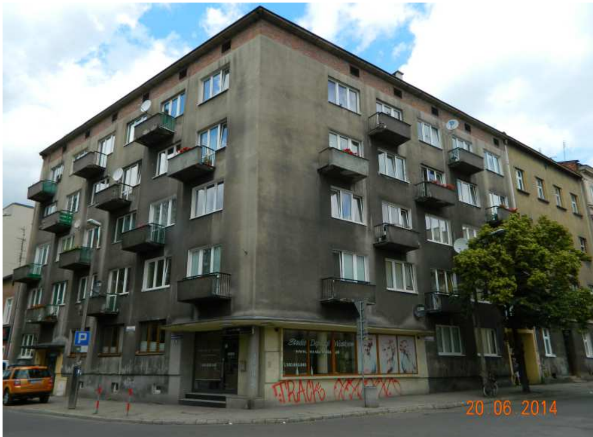
Fot. nr 53 (53-54). Powojenny blok z naroża ulic: Michałowskiego 19 i Czarnowiejskiej 3.
