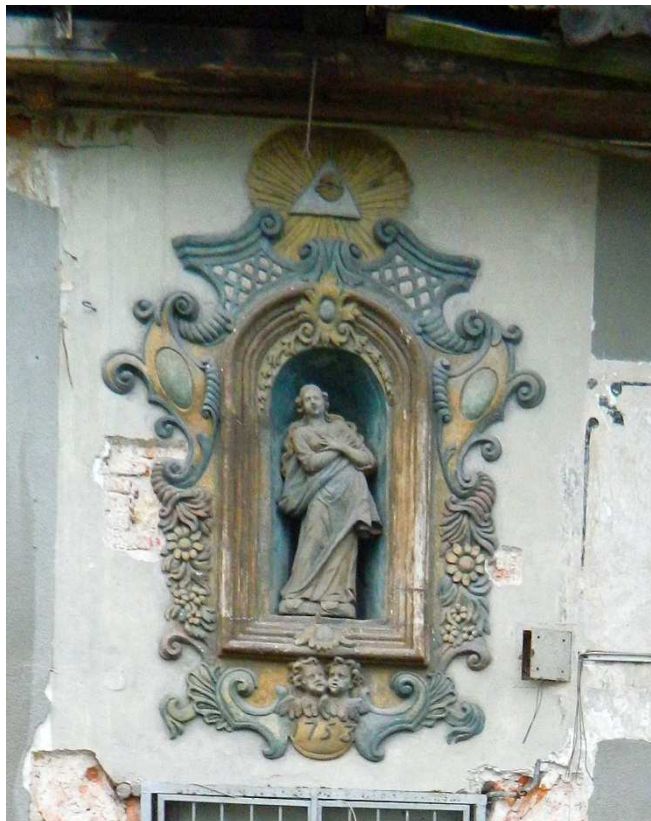
Fot. nr 107. Zabytkowa, rokokowa figura na ścianie zrujnowanego budynku usytuowanego na tyłach posesji pod nr 25. (30.09.2014)
