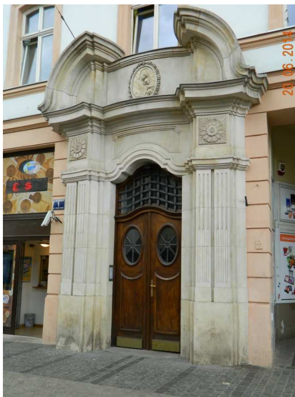
Fot. nr 151. Secesyjny portal kamienicy.
