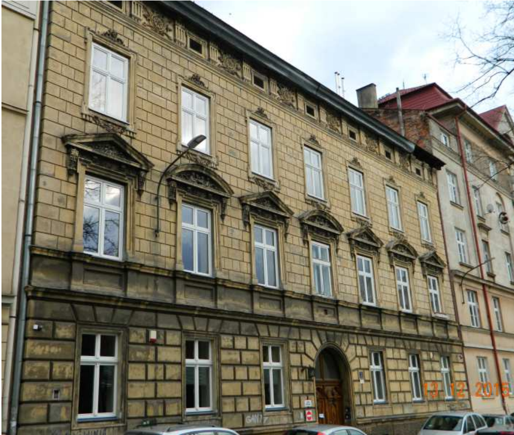
Fot. nr 202 (202-203). Eklektyczna kamienica z ulicy Asnyka 3 po wymianie okien.
