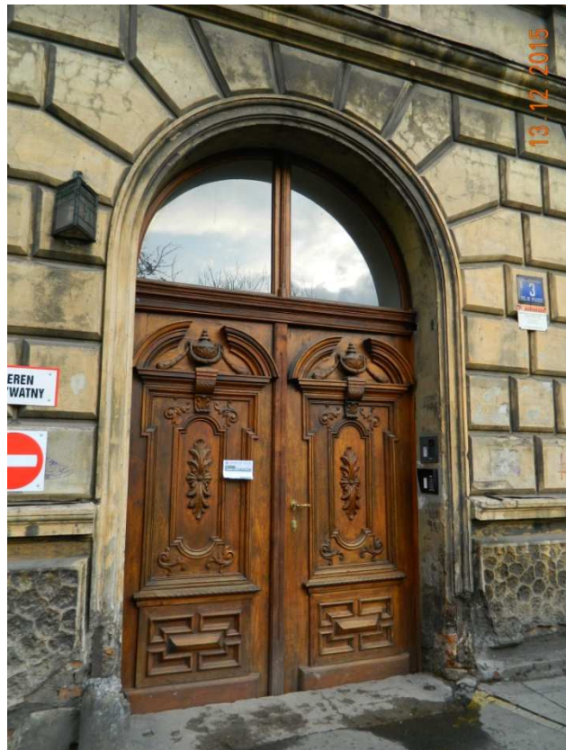
Fot. nr 203. Oryginalne drzwi kamienicy powstałej w ostatniej dekadzie XIX wieku.
