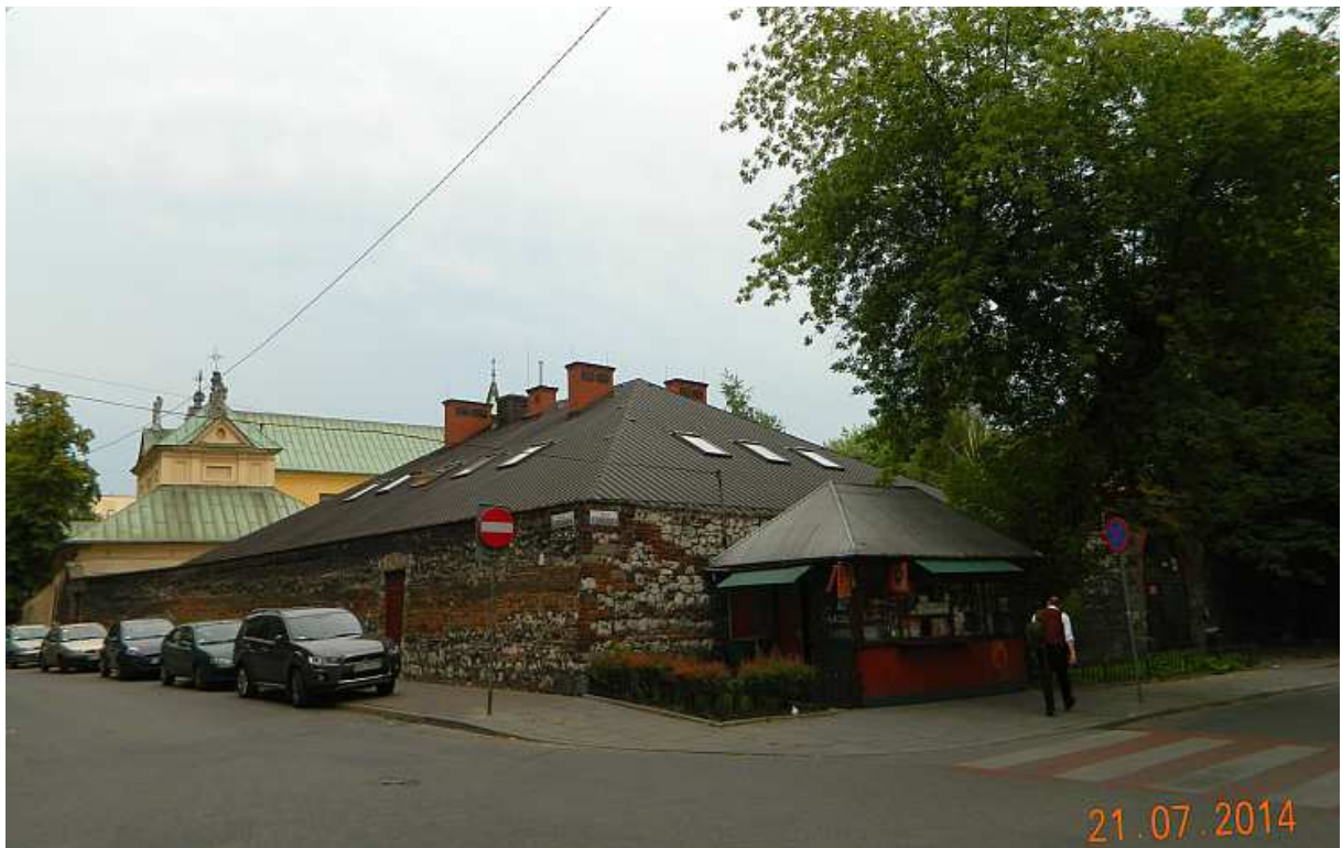
Fot. nr 239. Ujęcie kościoła z ulicy Studenckiej.
