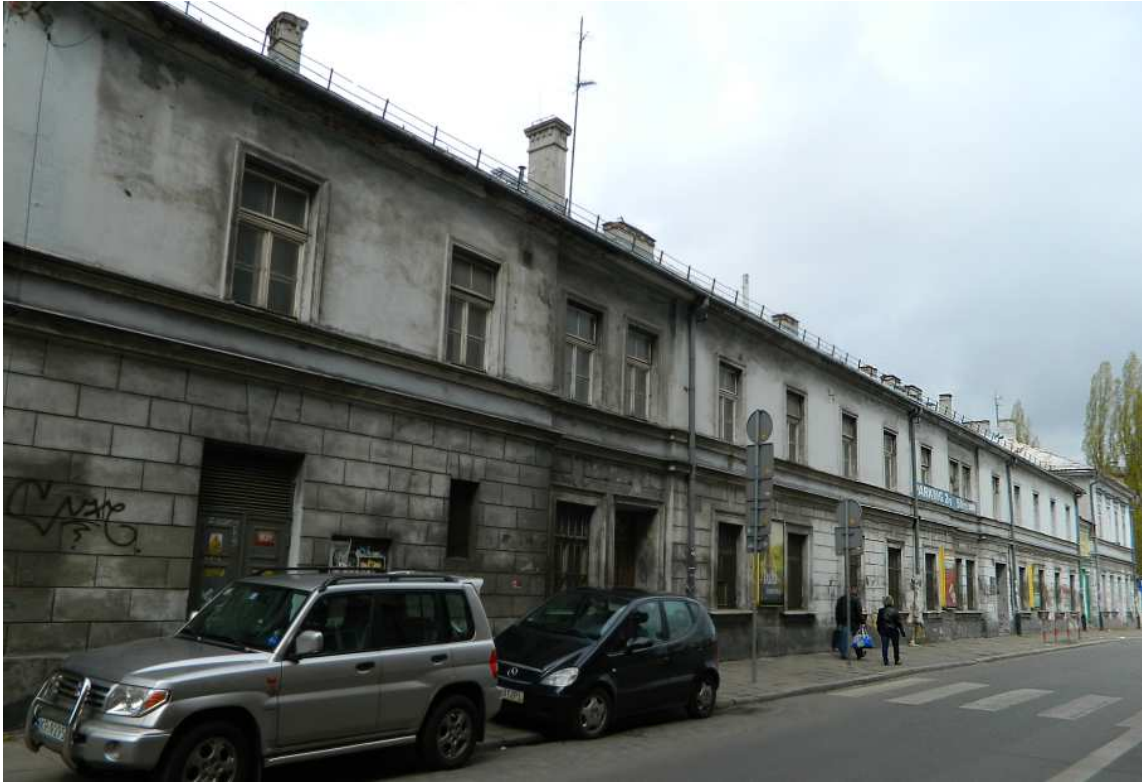
Fot. nr 40 (40-49). Kilka ujęć różnych budynków dawnych Zakładów Tytoniowych przy ulicy Dolnych Młynów 10-12, które zajmowały znaczny obszar ograniczony ulicą Czarnowiejską, aleją Mickiewicza i ulicą Czystą. W dawnych budynkach „spontanicznie” powstało centrum gastronomiczno-rozrywkowe. (15.04.2014)
