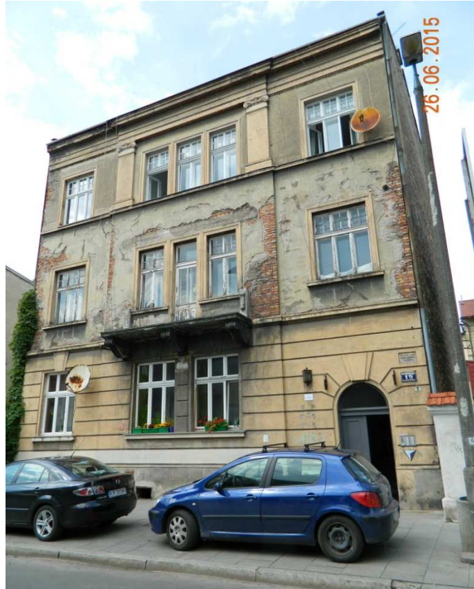
Fot. nr 56. Ponad stuletnia, modernistyczna kamienica spod 15.
