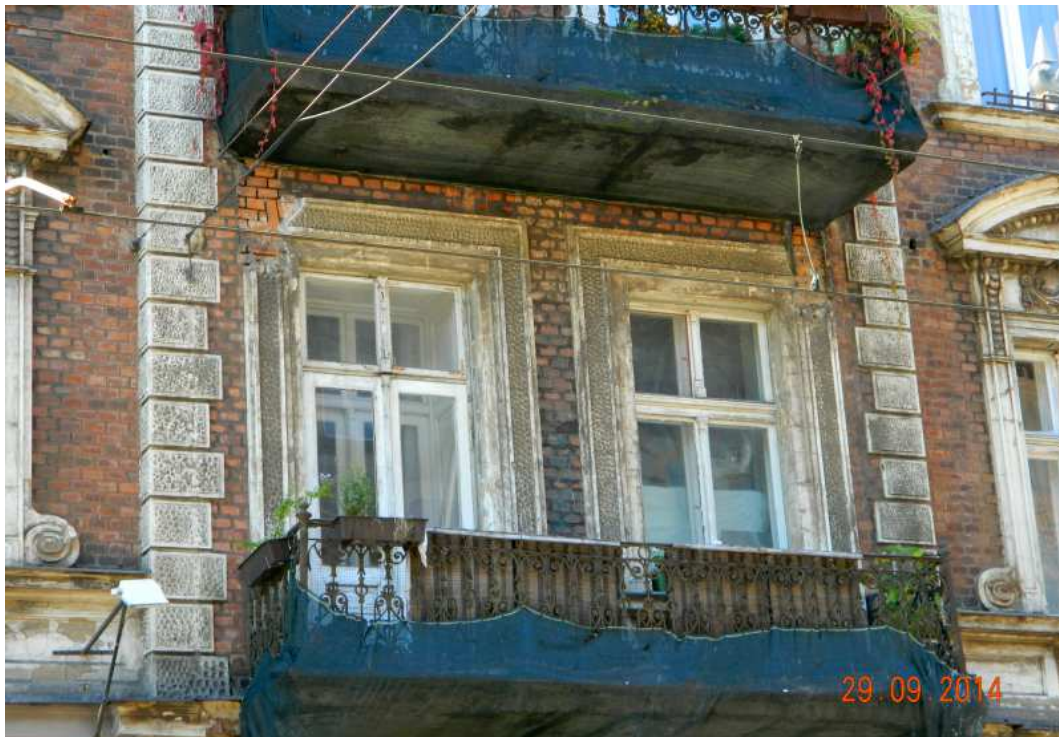
Fot. nr 87. Oryginalne detale okienne zachowane na I piętrze budynku.
