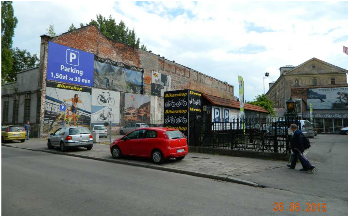
Fot. nr 60. Pusty plac po wyburzonym domu spod nr 4.
