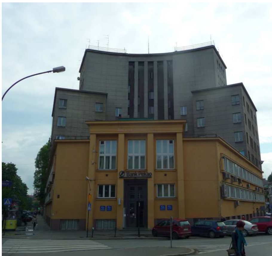
Fot. nr 216 (216-217). Dawny gmach Banku Rolnego przy ulicy Dunajewskiego 8, w narożu z ulicą Łobzowską. Jego budowa została rozpoczęta przed II wojną światową, ale ukończona dopiero po jej zakończeniu. Stoi w miejscu dawnego hotelu Krakowskiego, wyburzonego w połowie lat 30. XX wieku. (03.06.2014)
