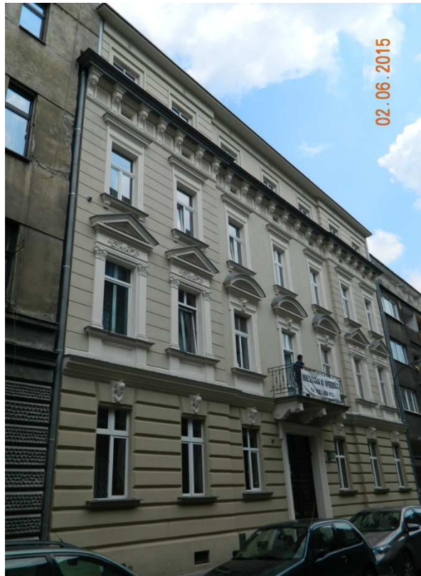
Fot. nr 8. Zeszepeczona nadbudówką (de facto o dwie kondygnacje) kamienica pod nr 11. Jej fasada dodatkowo koszmarną „galerię” okien o przeróżnych podziałach
