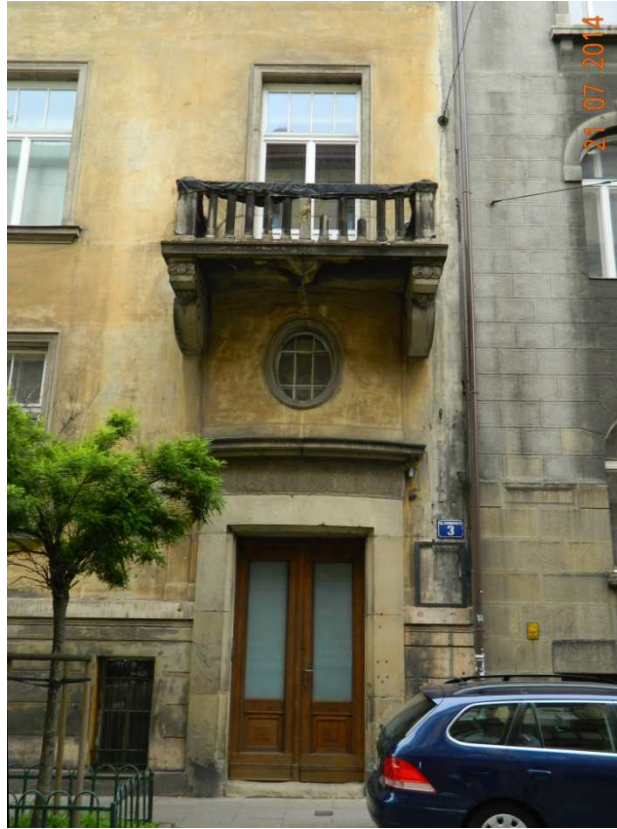
Fot. nr 242. Detale willi powstałej w latach 1909-1910.
