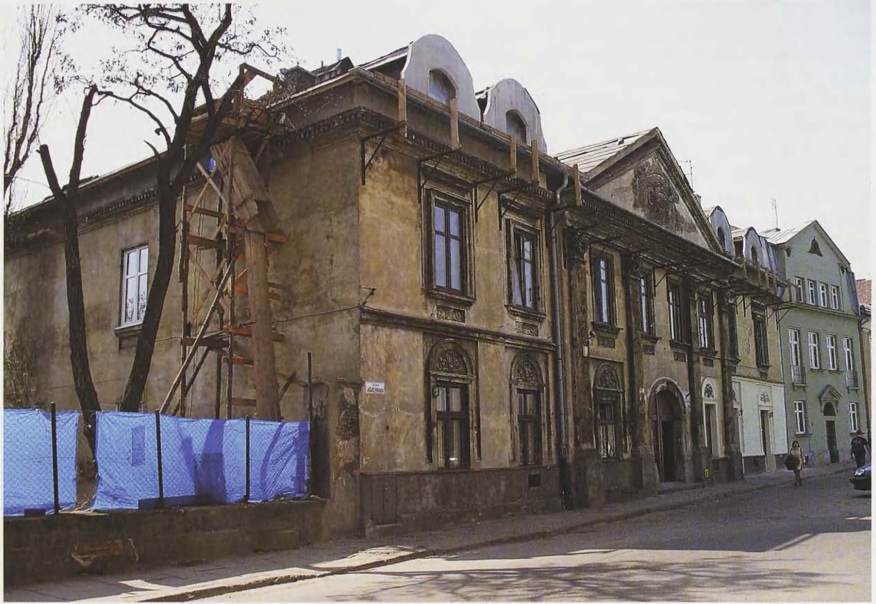
11. Dom „Pod Lwem” przy ul. Józefińskiej nr 4 w trakcie remontu
