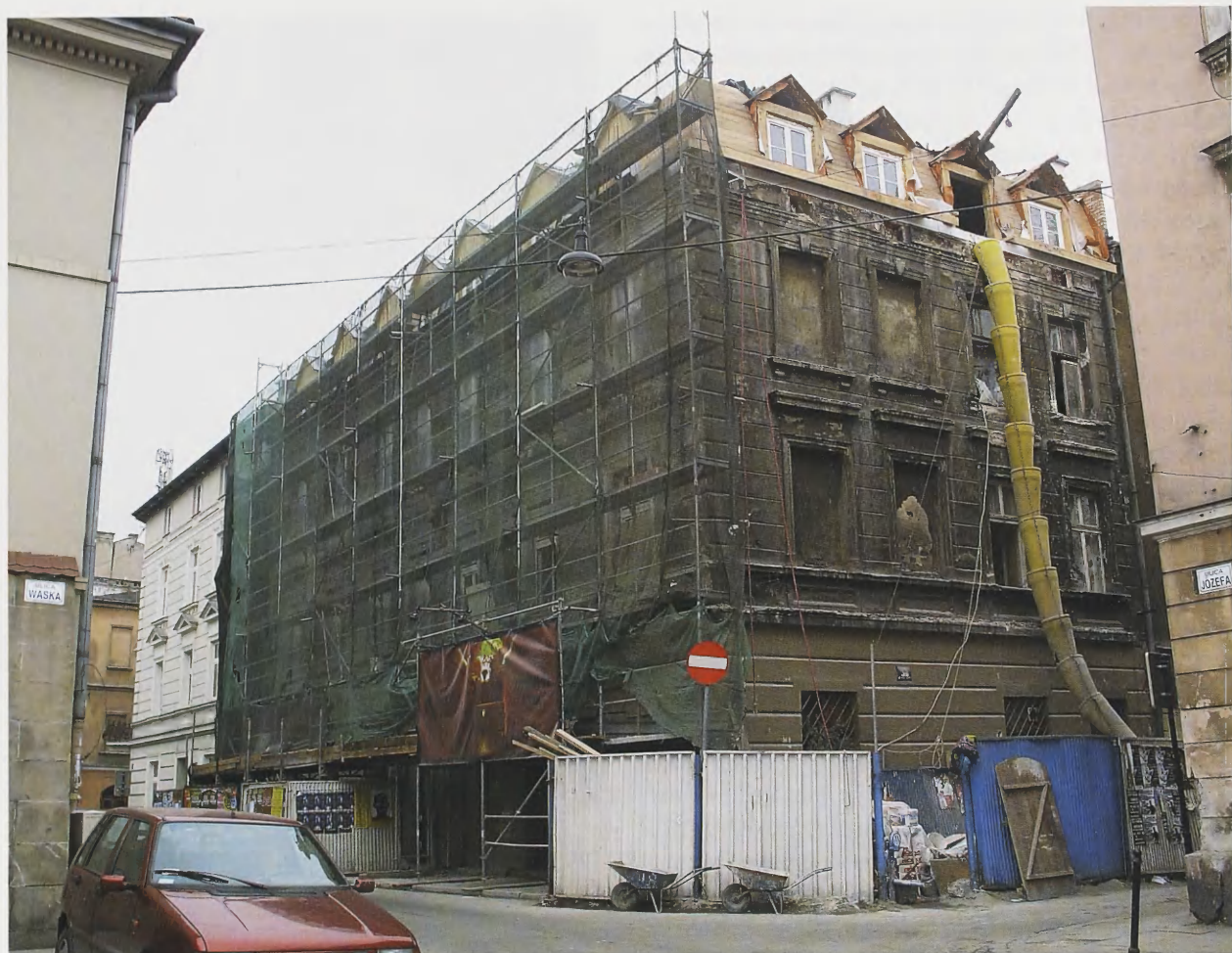
5. Kamienica przy ul. Józefa nr 34 w trakcie remontu
