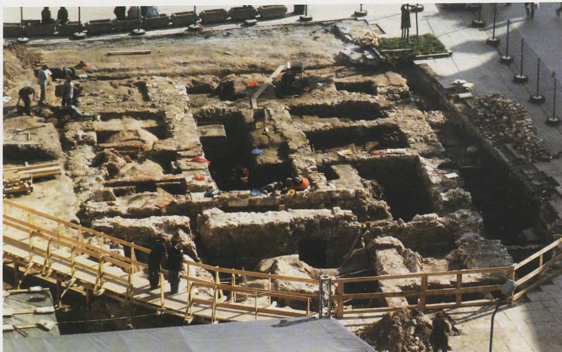
3. Relikty Wagi po odsłonięciu, stan z późnego lata 2005 r. Widok od zachodu, z wieży ratuszowej, fotografia Tomasza Kalarusa. Granice odkrywek wyznaczają obrys wagi średniowiecznej wraz z przybudówkami od wschodu. Liczne późniejsze mury dzielą na mniejsze pomieszczenia jednolitą przestrzeń pierwotnego wnętrza w części wschodniej
