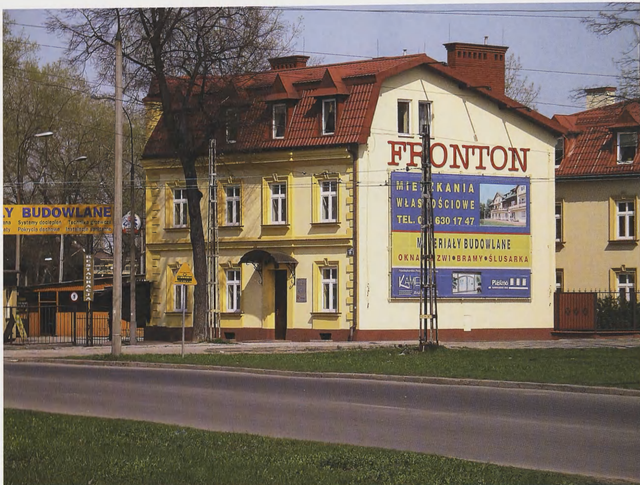
14. Dom przy ul. Kamiennej nr 19 po remoncie
