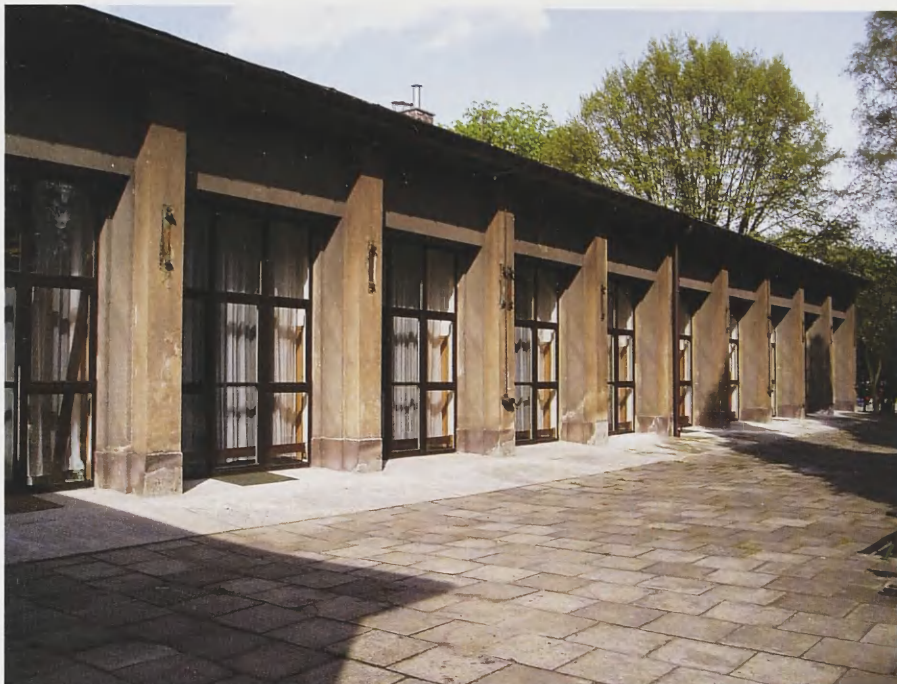
28. Czesław Boratyński i Edward Kreisler, fragment elewacji południowej dawnego pawilonu Krakowskiego Towarzystwa Przeciwgruźliczego przy ul. Reymonta 18; fot. B. Zbroja, 2006 r.
