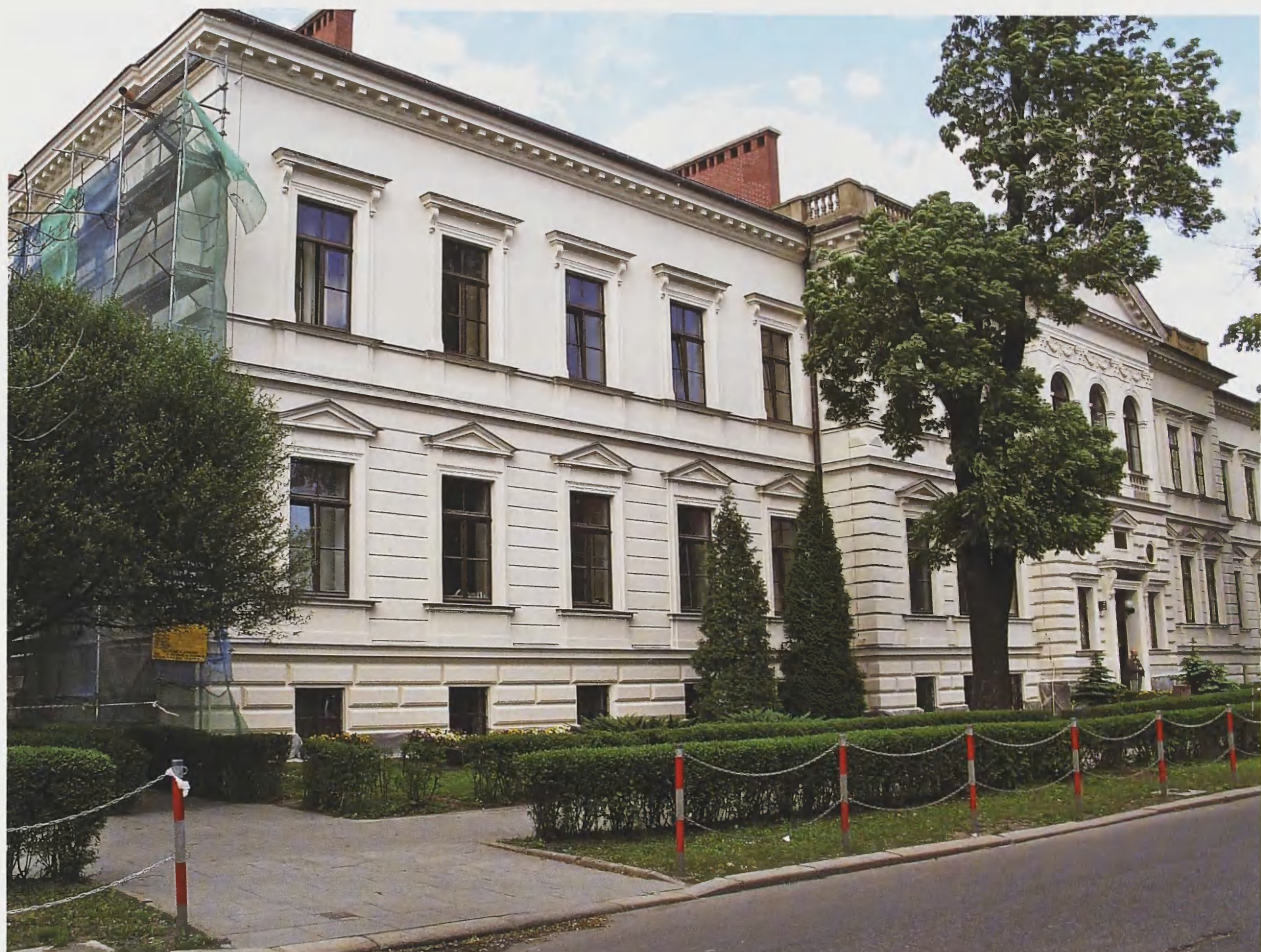
9. I Klinika Chirurgii przy ul. Kopernika nr 40 w trakcie remontu
