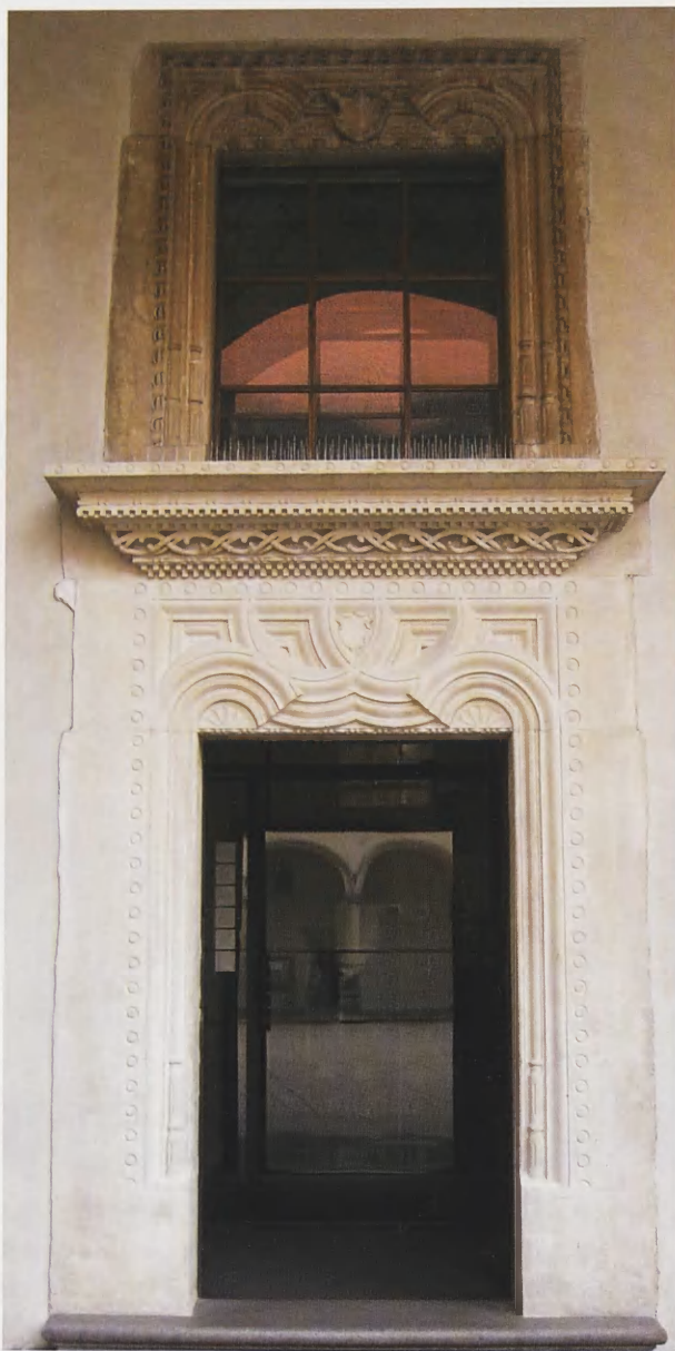
21. Benedykt, portal i nadświetle we wschodnim skrzydle Zamku Królewskiego na Wawelu, 1524–1529
