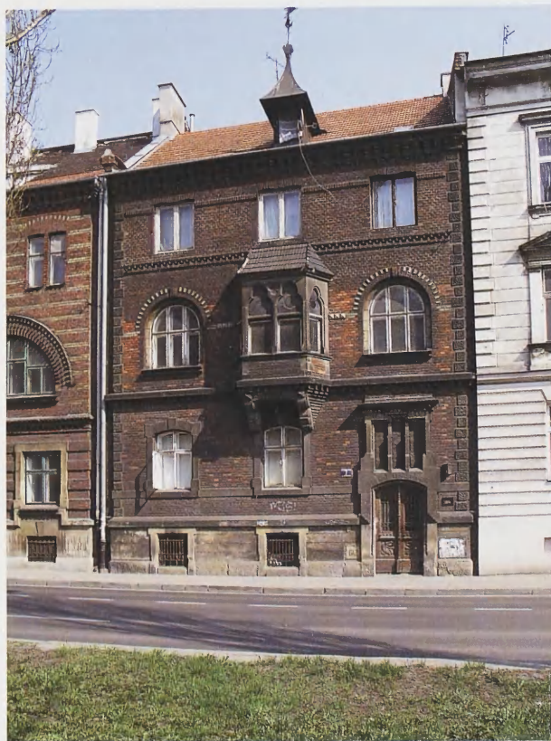
10. Kamienica przy al. Słowackiego nr 7 w trakcie remontu
