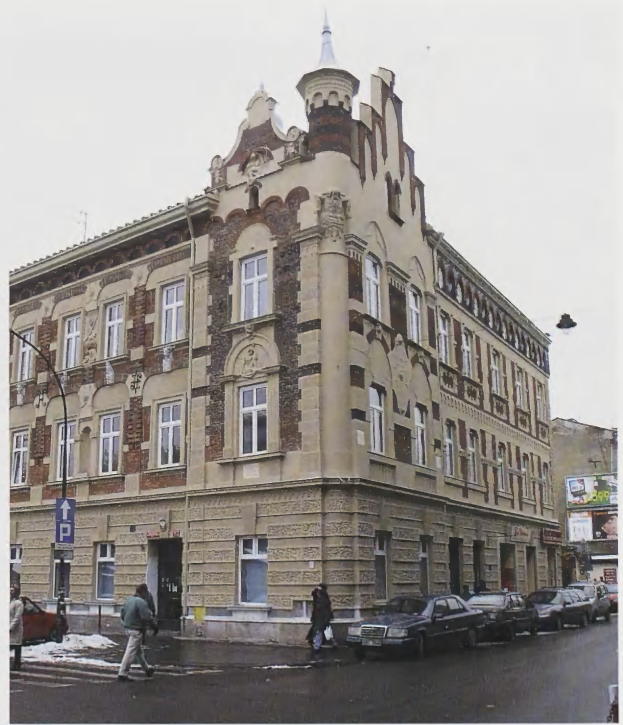
7. Kamienica przy ul. Św. Filipa nr 16 po remoncie
