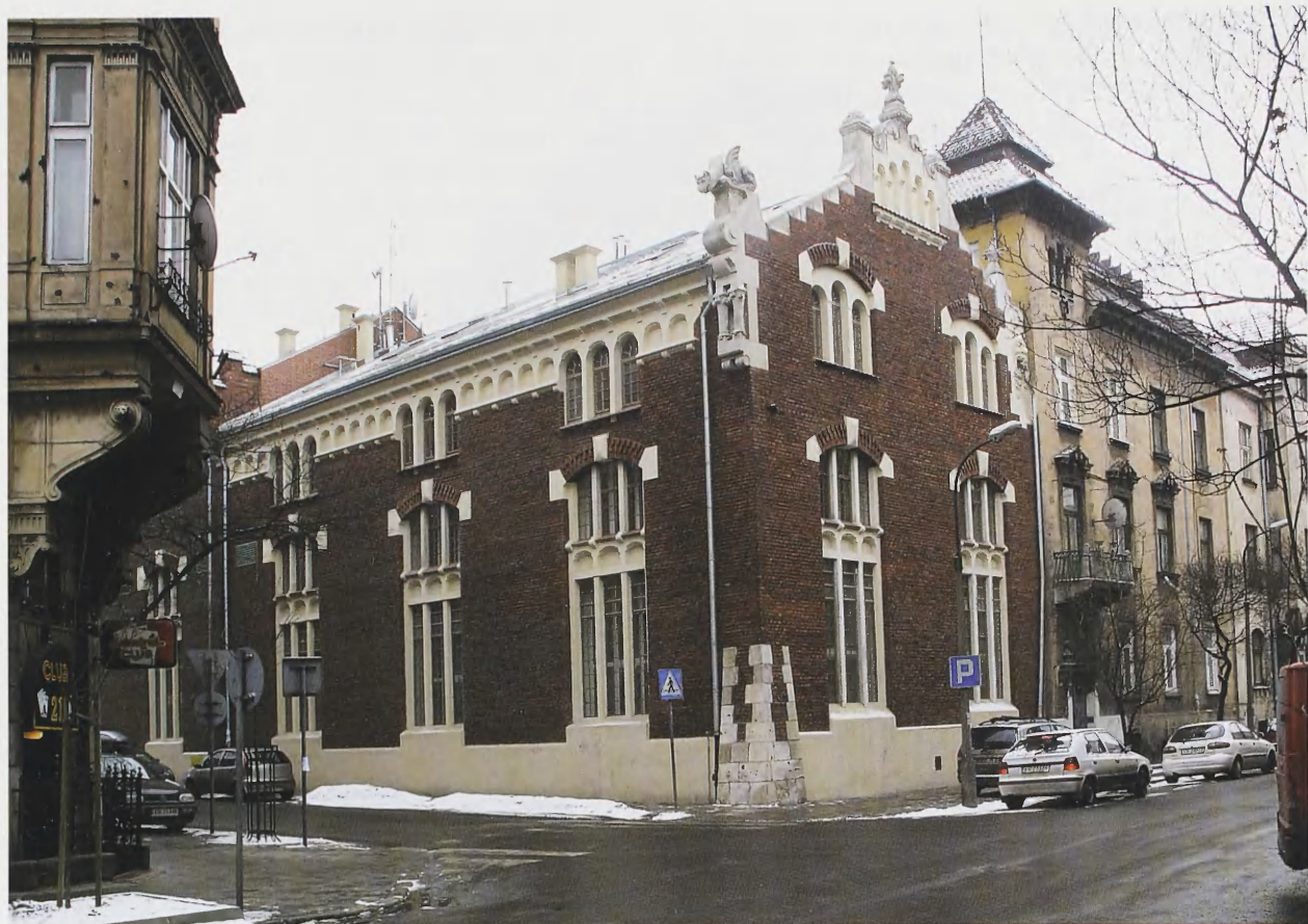
6. Podstacja elektryczna przy ul. Asnyka i Łobzowskiej nr 11 po remoncie
