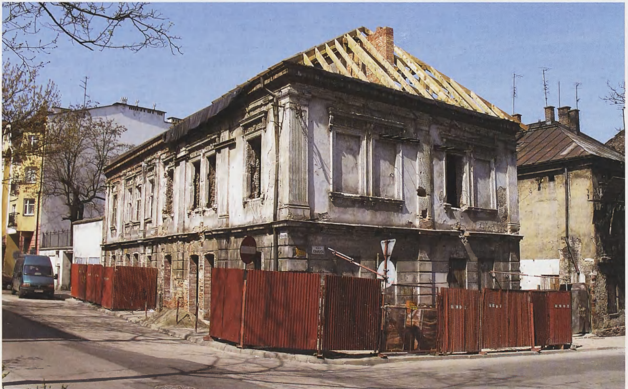
12. Dom przy ul. Rękawka nr 15 w trakcie remontu
