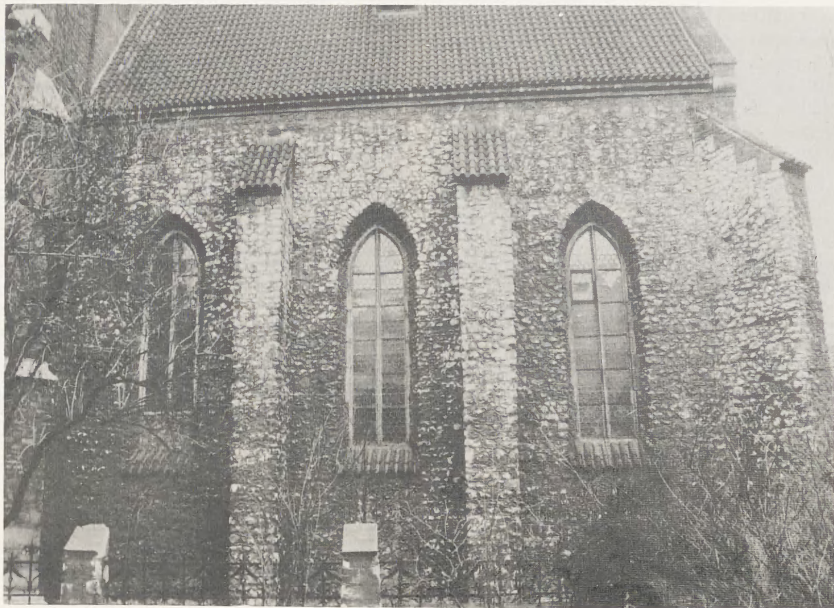
10. Kościół Św. Krzyża, elewacja południowa prezbiterium
