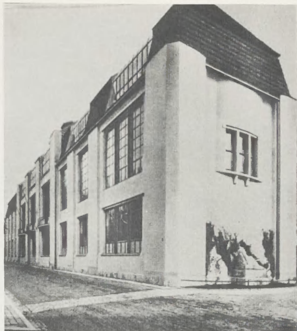
22. Weimar, budynek Szkoły Sztuk Pięknych (później siedziba Bauhausu) proj. H. van de Velde, 1904 (wg J. Joedicke, Geschichte der modernen Architektur... )
