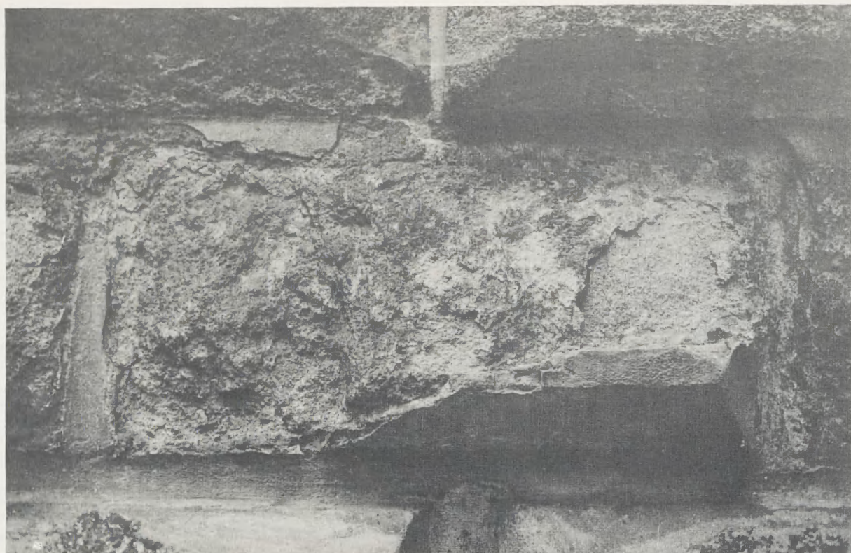
33. Całkowicie zniszczony blok wapienia ze śladami dawnych napraw cementowych. Rustyka pałacu w Książu Wielkim (1585–1595)
