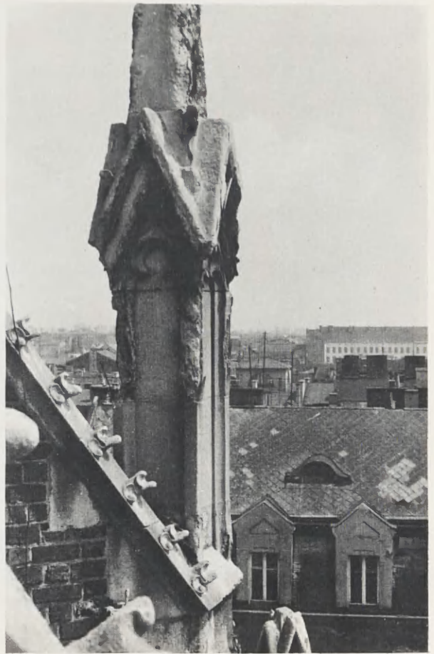
7. Zwieńczenie (koniec XIX wieku) przypory w prezbiterium kościoła Św. Katarzyny oraz okapik przypory (połowa XIV wieku). Różne bloki wapienia wykazują kontrastowo różny stopień zachowania, od daleko posuniętych zniszczeń (większość elementów z XIX wieku) do bardzo dobrego (dekoracje z XIV wieku)
