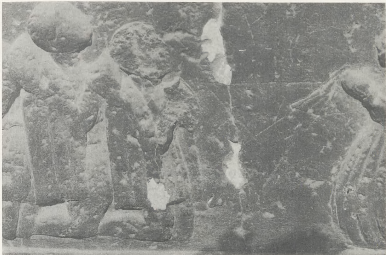
20. Epitafium w kościele Mariackim, fragment ryc. 3. Pęknięcia i odpryski twardej kory zwietrzelinowej odsłaniającej osłabiony i osypujący się wapienie o wysokiej zawartości gipsu
