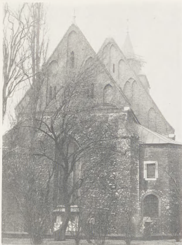
9. Kościół Św. Krzyża, elewacja wschodnia prezbiterium
