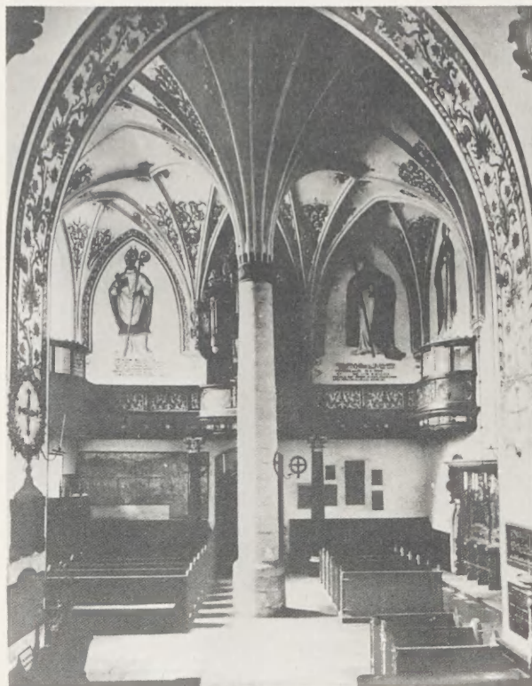
11. Kościół Św. Krzyża, wnętrze nawy od strony prezbiterium, po roku 1898
