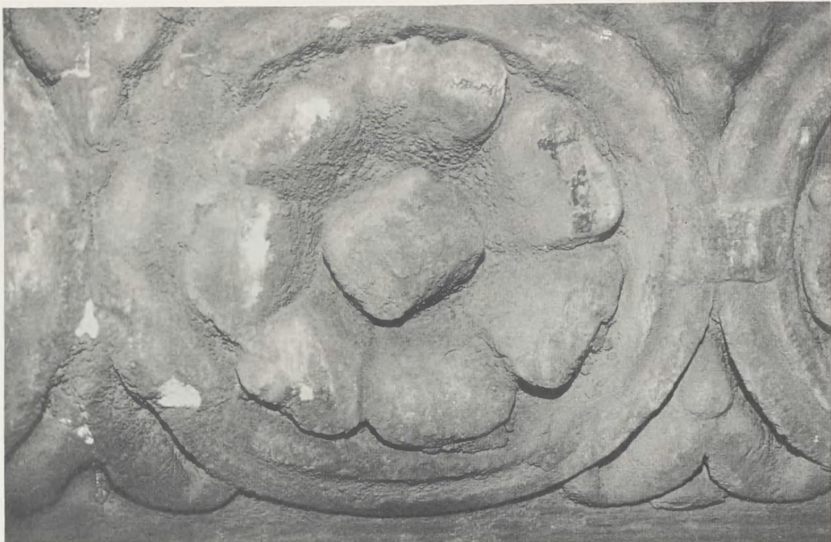
22. Arkada wewnętrznej sieni wjazdowej zamku na Wawelu, fragment ryc. 16. Charakterystyczne, nieregularne narośla gipsowe widoczne w wewnętrznej części rozety
