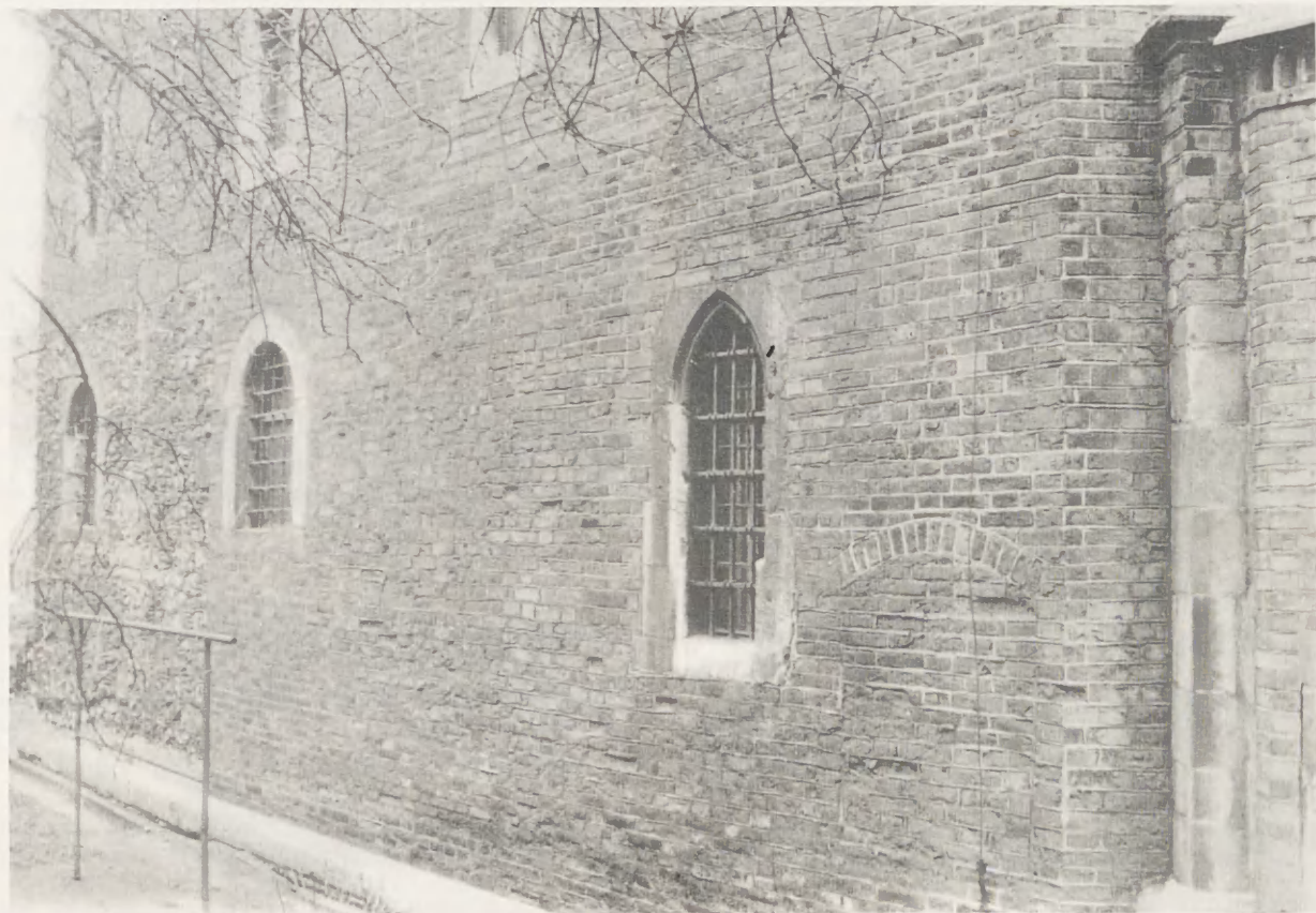
20. Kościół Św. Krzyża, elewacja przybudówki znajdującej się po północnej stronie prezbiterium
