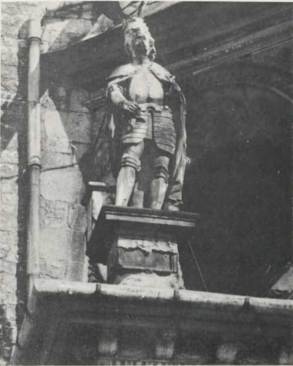
4. Kaplica Wazów w katedrze na Wawelu (1664–1676). Daleko posunięta korozja rzeźb z wapienia pińczowskiego doprowadziła w znacznym stopniu do zatarcia ich pierwotnej formy
