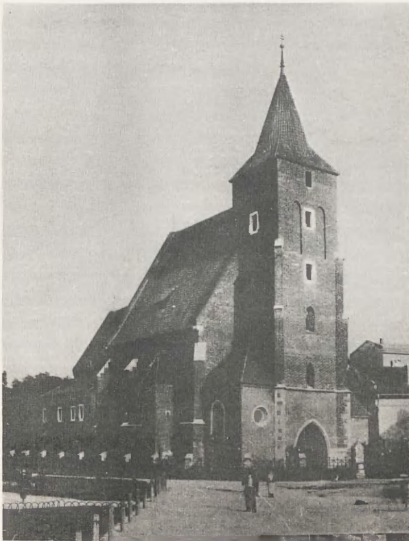
4. Kościół Św. Krzyża od północnego zachodu po roku 1898
